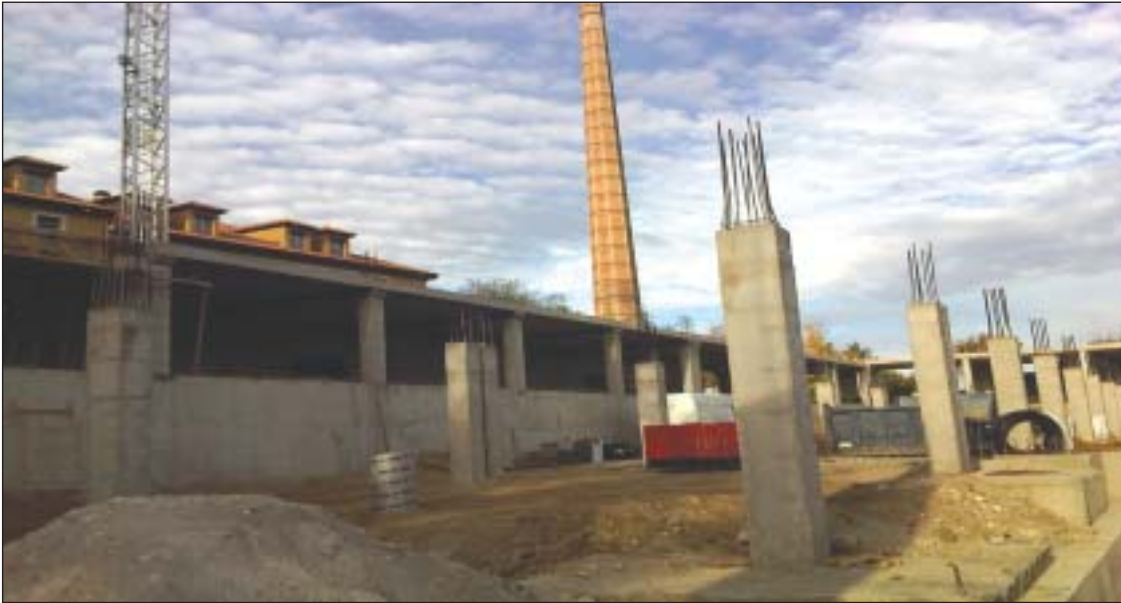
Obras de las instalaciones geotérmicas en el Hotel Balcón del Eresma en Segovia.
