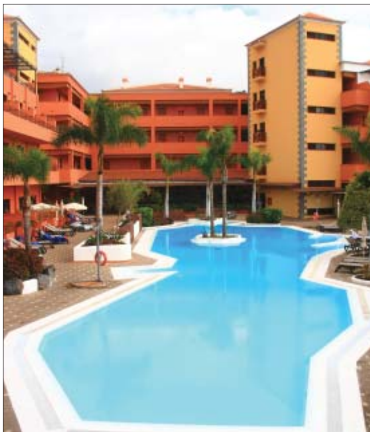
Aspecto de las piscinas una vez renovadas.
