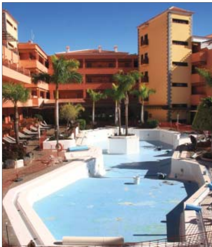
Aspecto de las piscinas antes de la renovación.
