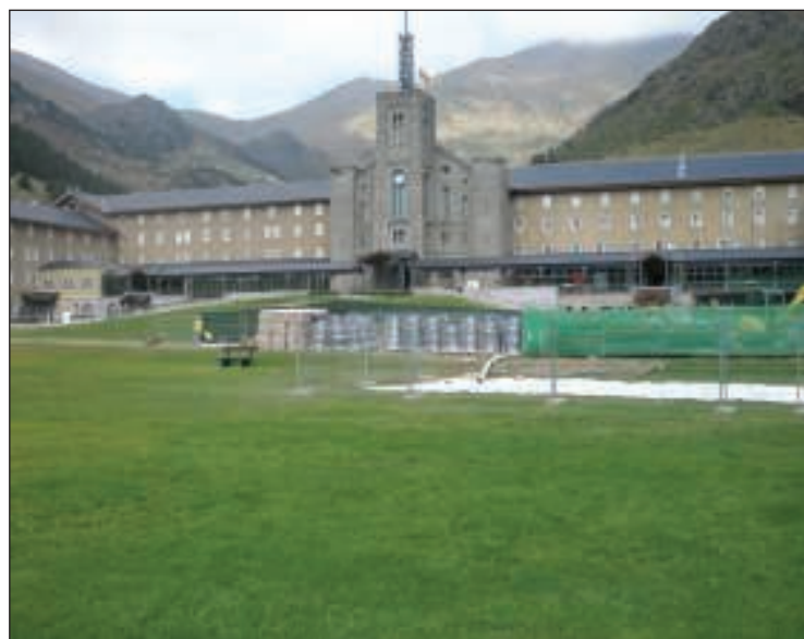
Fachada principal del edificio Sant Josep de Vall de Núria en rehabilitación.
